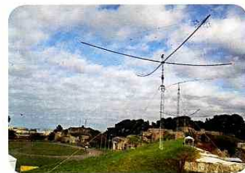
Vue générale des antennes.
