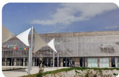
Lycée Maritime Florence Arthaud avec les antennes radio sur le toit
